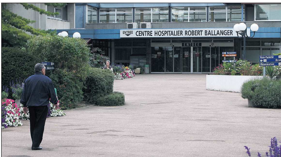
AULNAY, HOPITAL BALLANGER. Hormis le plateau technique récent, tous les bâtiments seront transformés. La première phase de travaux doit être terminée dans cinq ans. (LP/G.P.)
